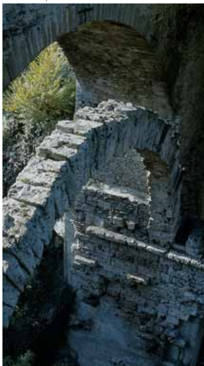
▼ I resti del ponte romano di Châtillon
